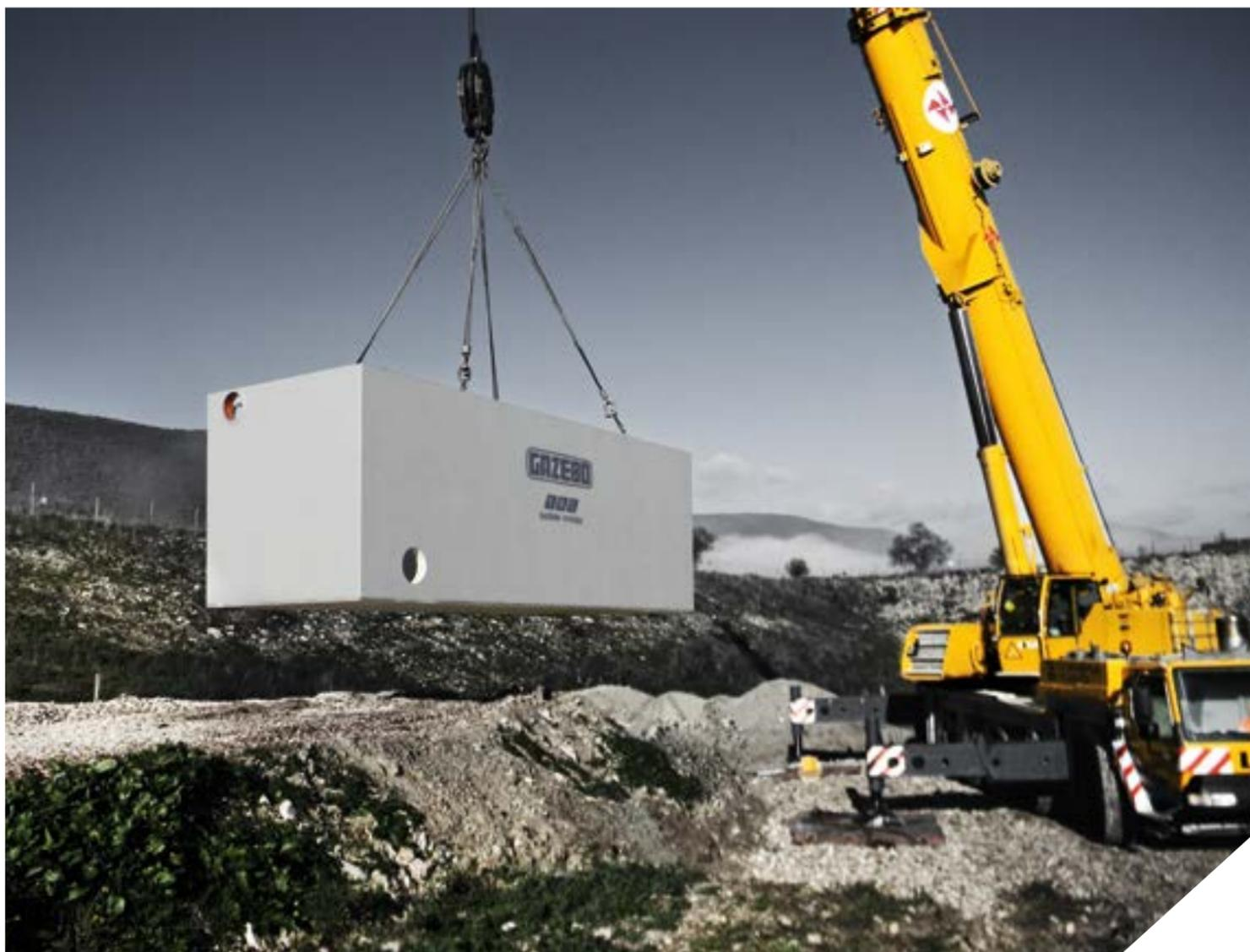
Les réservoirs préfabriqués de rétention des eaux pluviales, également appelés cuves à invariance hydraulique ou volant d'inertie, sont installés pour faire face et résoudre l'un des problèmes les plus graves et les plus actuels concernant l'environnement et le territoire : les variations de débits liées aux crues des cours d'eau, des rivières et, plus généralement, de toutes les masses d'eau de surface.
