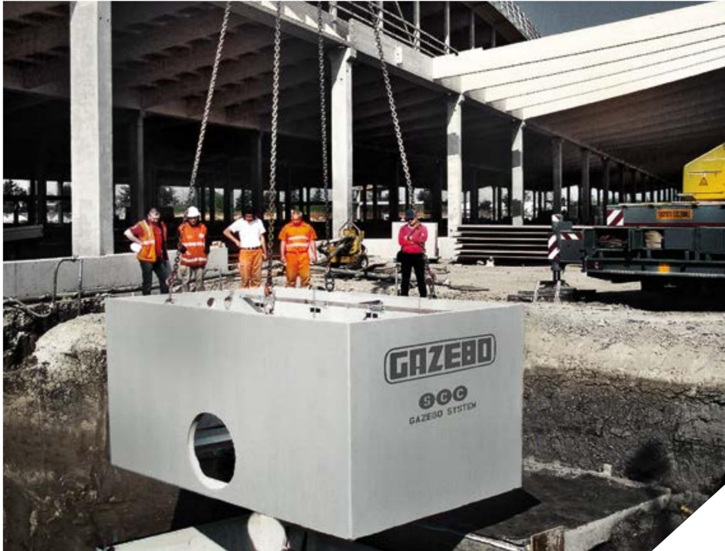
Les Stations de Relevage et Pompage Préfabriquées Gazebo, utilisées pour le relevage des eaux usées civiles et industrielles et des eaux potables, sont fournies entièrement équipées de pompes de relevage, de tubes de guidage, de canalisations de refoulement, de vannes, de sondes de niveau, ainsi que d'un tableau électrique, éventuellement de type urbain, et des accessoires nécessaires à leur bon fonctionnement.
