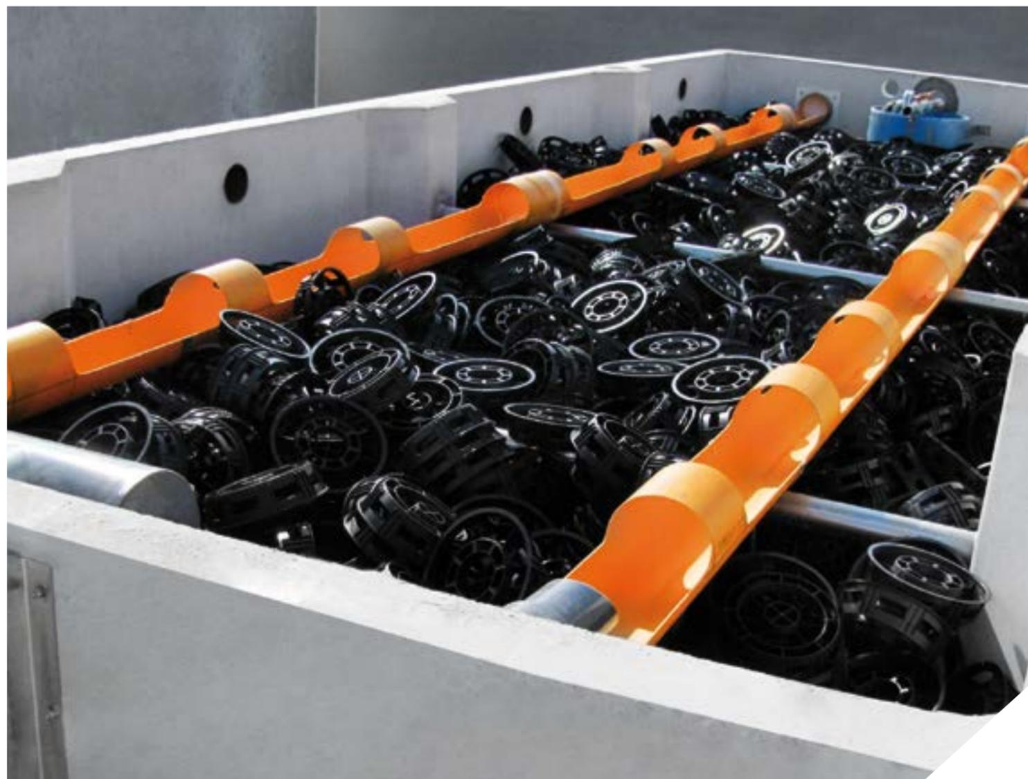
Les eaux clarifiées en sortie de la Fosse Septique de type Imhoff sont traitées dans le Filtre Percolateur Aérobie, contenant des corps de remplissage en plastique (éléments circulaires à fort rapport surface/volume). Grâce à un processus impliquant des micro-organismes aérobies fixés sur ces corps de remplissage, la matière organique restante dans les effluents diminue encore plus.
