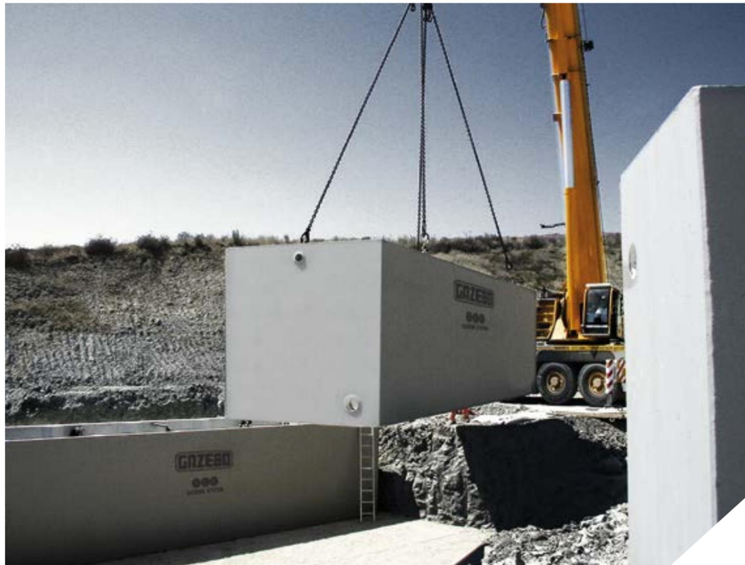
Les cuves préfabriquées en béton armé Gazebo, réalisées en monobloc à l'aide des révolutionnaires systèmes « **SCC Gazebo System** » ou « **FRC Gazebo System** », assurent une absence totale de fuites hydrauliques et d'infiltrations dans le sol. Elles sont utilisées pour le stockage de substances liquides et solides comme :
