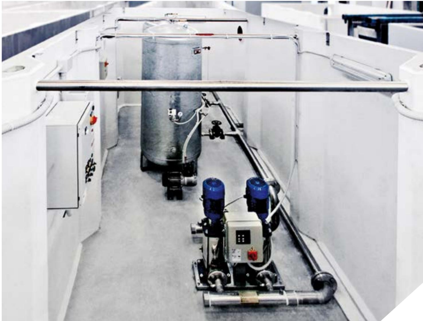
Les Installations de Pressurisation Hydraulique Gazebo pour le secteur civil ou industriel se composent de cuves monoblocs préfabriquées en B.A., basées sur les révolutionnaires systèmes « **FRC Gazebo System** » ou « **SCC Gazebo System** » (utilisées comme réserve d'eau et local technique), et elles sont équipées de systèmes de pompage/pressurisation adéquats.
