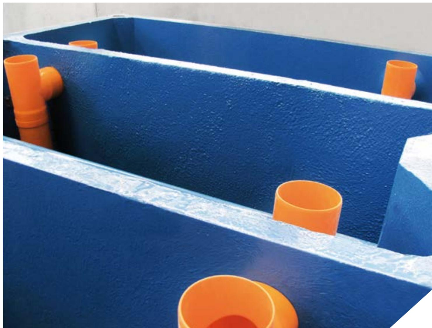
Les Dégraisseurs Statiques sont utilisés plus particulièrement pour traiter les eaux usées des cuisines caractérisées par la présence de substances polluantes, telles que huiles et graisses animales/végétales.
