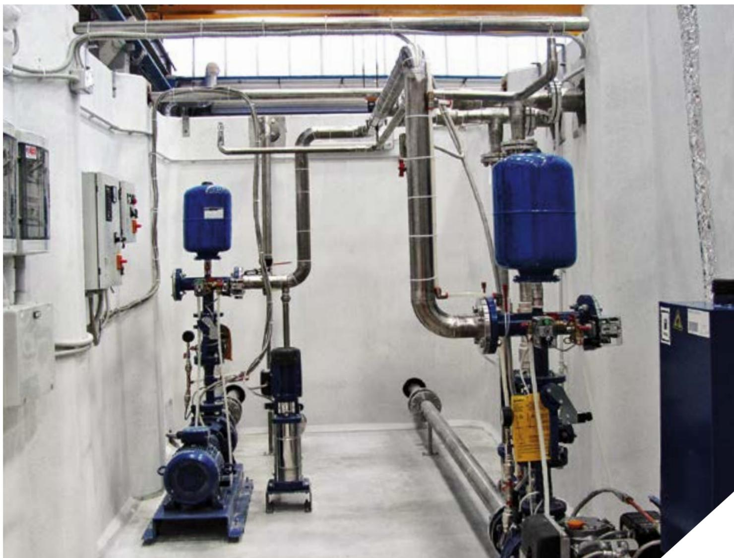
Les Systèmes Fixes de Lutte contre l'Incendie Gazebo – avec sprinklers ou bouches d'incendie – se composent de cuves préfabriquées, avec groupes de pressurisation, réserve d'eau et local technique monobloc en B.A., basés sur les révolutionnaires systèmes « **FRC Gazebo System** » ou « **SCC Gazebo System** ».
