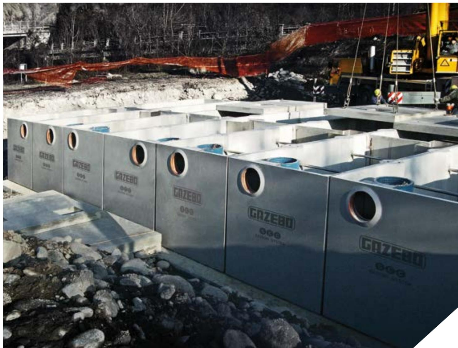
Parfois improprement appelées « cuves de premières eaux de pluie », les installations de traitement des eaux en continu conçues par Gazebo ont pour fonction spécifique de traiter de manière statique, sans l'aide d'organes électromécaniques, les premières eaux de pluie ruisselant sur des surfaces découvertes, afin de les évacuer vers le récepteur final.
