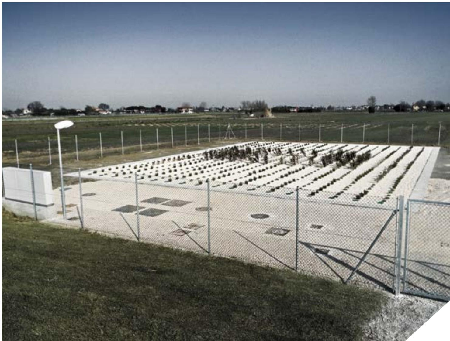
Le système de traitement se compose d'une phase de prétraitement des effluents (par exemple, Dégraisseur Statique, Fosse Septique de type Imhoff) et d'une phase biologique naturelle (traitement secondaire) réalisée par un système de phytoépuration à flux vertical sous-surface, constitué d'un bassin étanche rempli de matériau inerte et présentant une couverture végétale superficielle composée de macrophytes.
