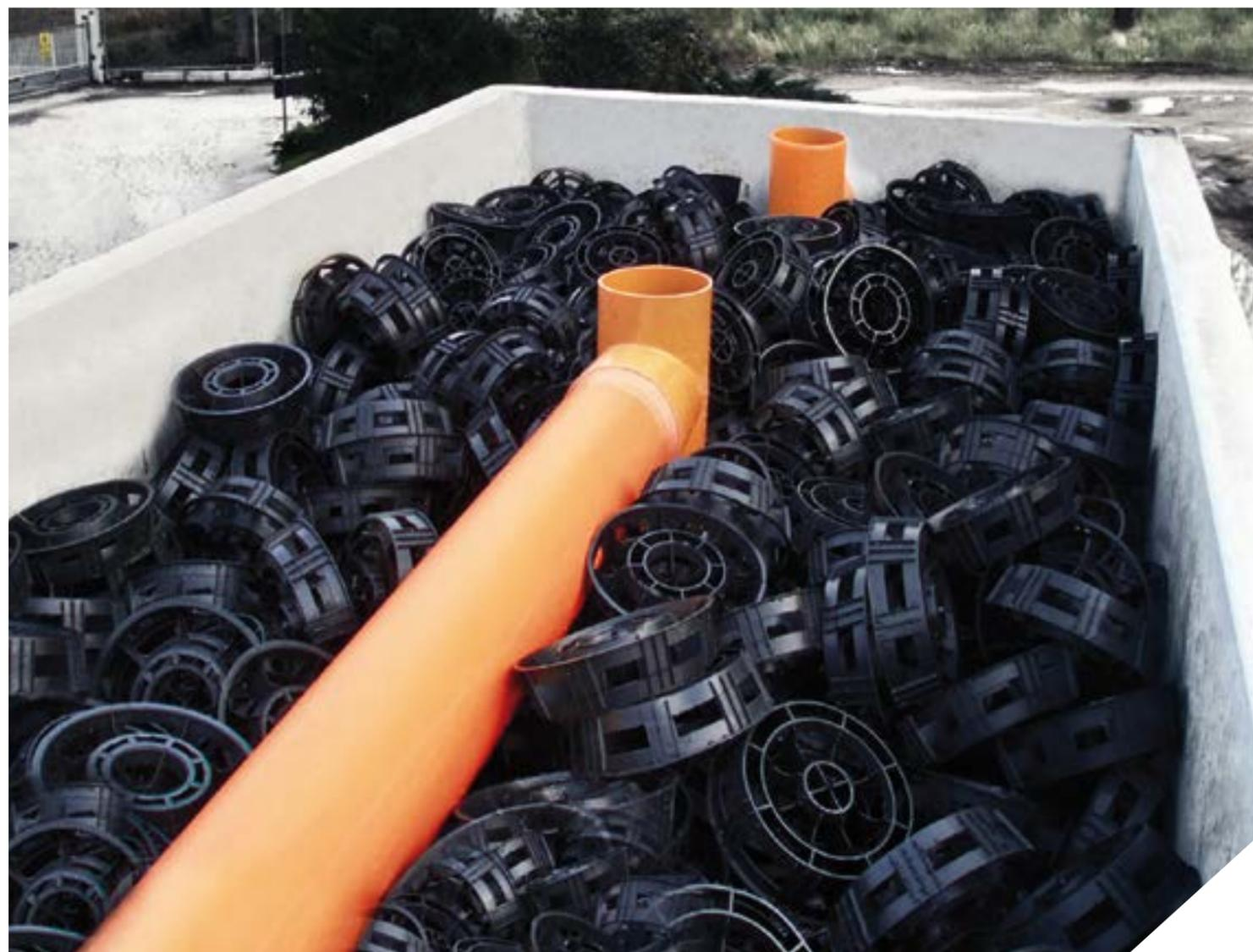
Les eaux clarifiées, en sortie de la Fosse Septique de type Imhoff, sont acheminées vers la partie inférieure du Filtre Percolateur Anaérobie, contenant des corps de remplissage en matériau plastique (éléments circulaires à fort rapport surface/volume), puis remontent lentement jusqu'au déversoir.
