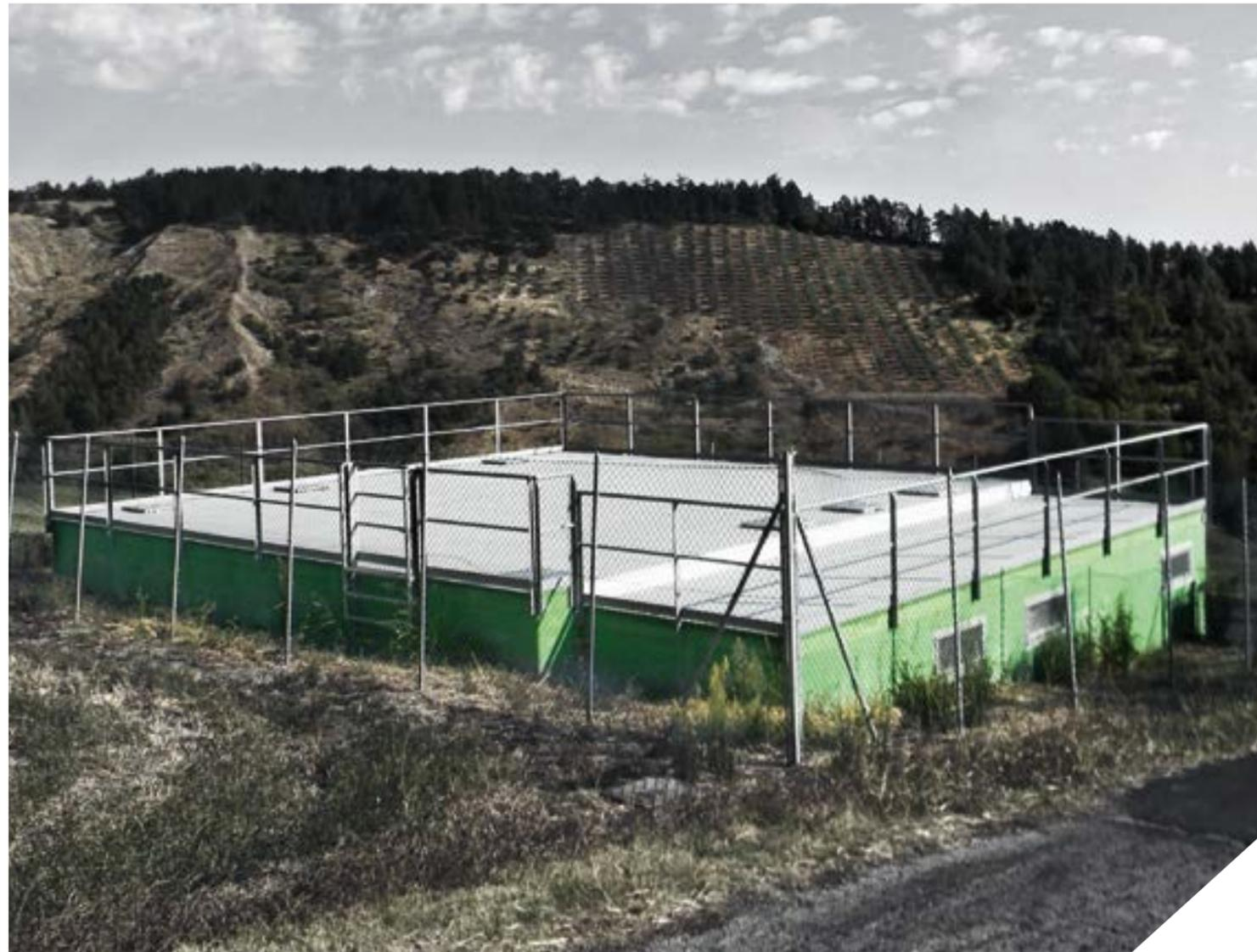
Les cuves préfabriquées en béton armé Gazebo, réalisées en monobloc à l'aide des révolutionnaires systèmes « **FRC Gazebo System** » ou « **SCC Gazebo System** », assurent une absence totale de fuites hydrauliques et d'infiltrations dans le sol. Elles représentent un système avantageux pour le stockage et l'accumulation d'eau potable.
