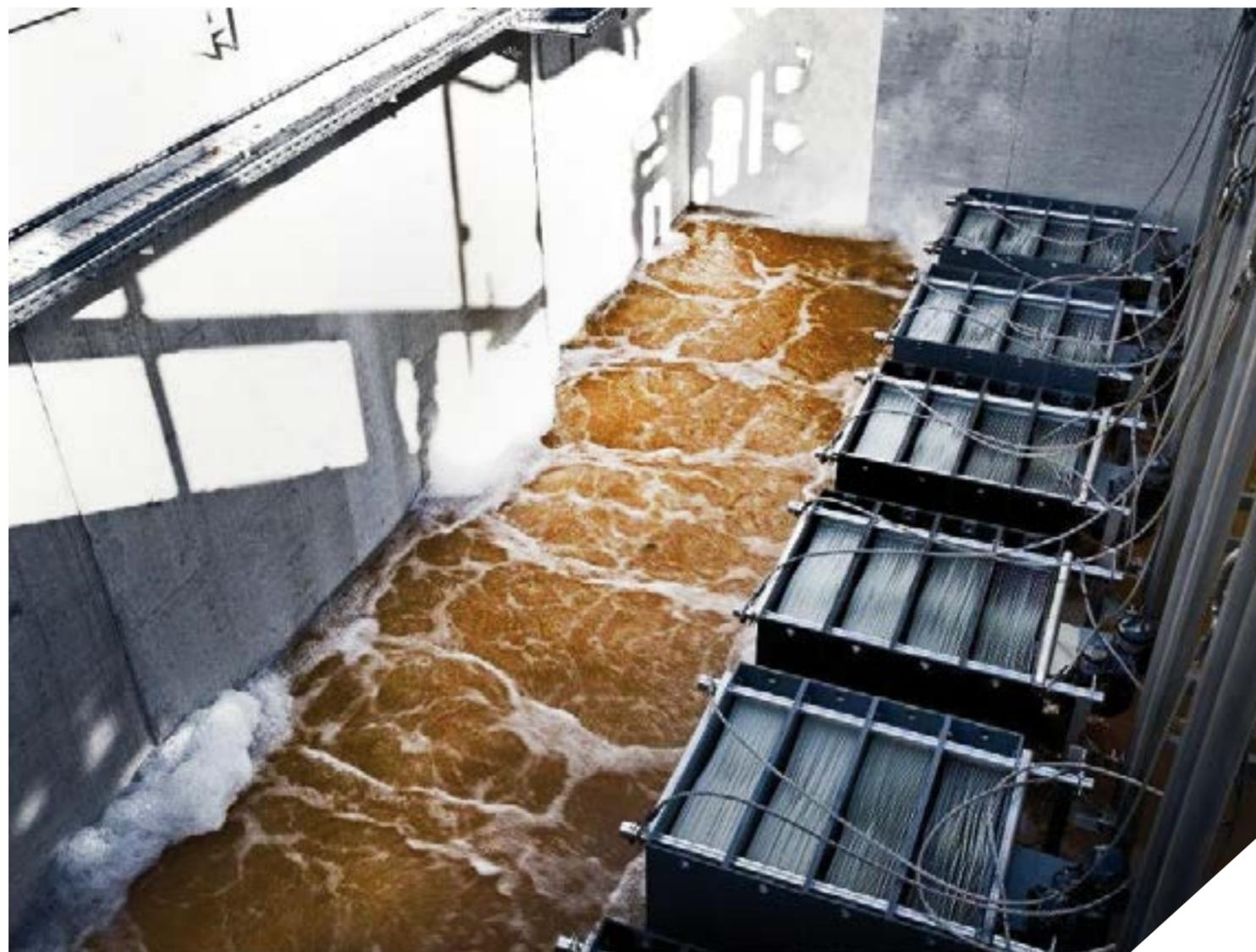
Dans une Installation d'Épuration MBR (Membrane Biological Reactor - Réacteur biologique à membrane), la technologie de l'épuration biologique à boues activées est associée à celle de l'ultrafiltration des boues à travers des membranes remplaçant les décanteurs secondaires traditionnels.
