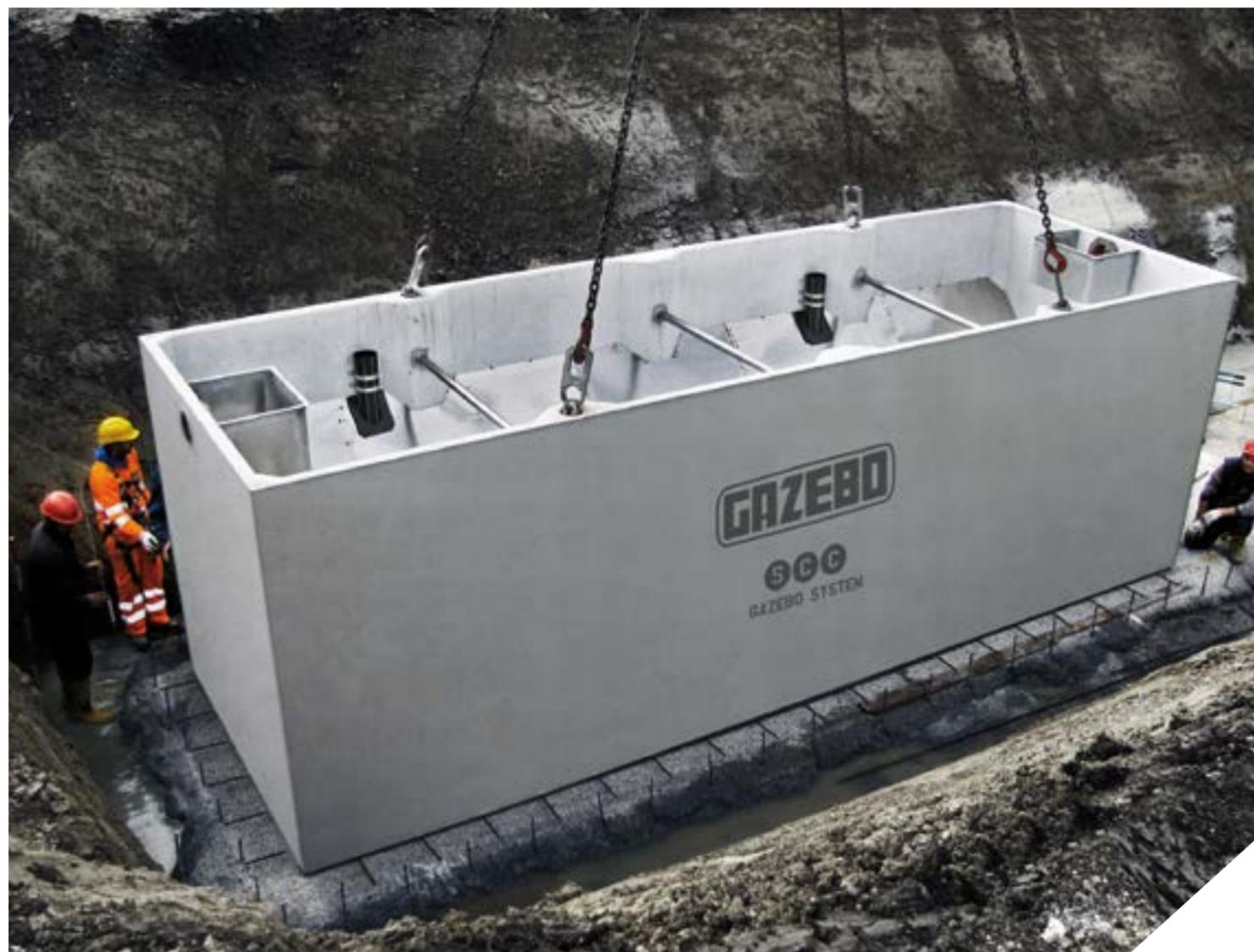
Les Fosses Septiques de type Imhoff, dimensionnées conformément aux exigences du Journal Officiel n° 48 du 21 février 1977, se composent de deux compartiments intérieurs : un compartiment supérieur de décantation et un compartiment inférieur de digestion.
